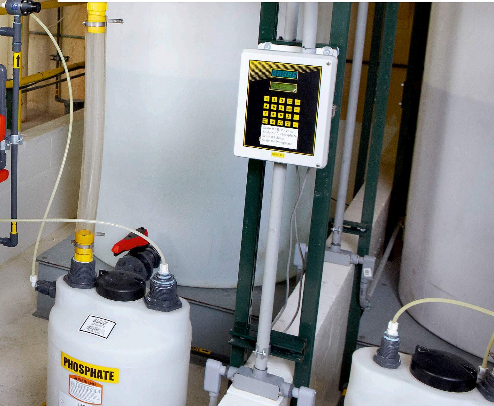
Die Steuerungstechnik der Chemikaliendosieranlage umfasst einen Multitouch-Control-Panel als HMI-Hardware, EtherCAT-Klemmen und einen Embedded-PC CX2030 (Bild).
