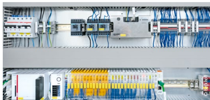
Die komplette Steuerung und Überwachung des Prototyps läuft auf einem Embedded-PC CX2040 (unten links) mit Intel®-Core™-i7- CPU und vier Prozessorkernen.
