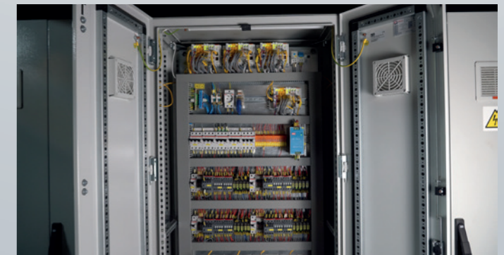
4 db ponthúzó vezérlőszekrénye
