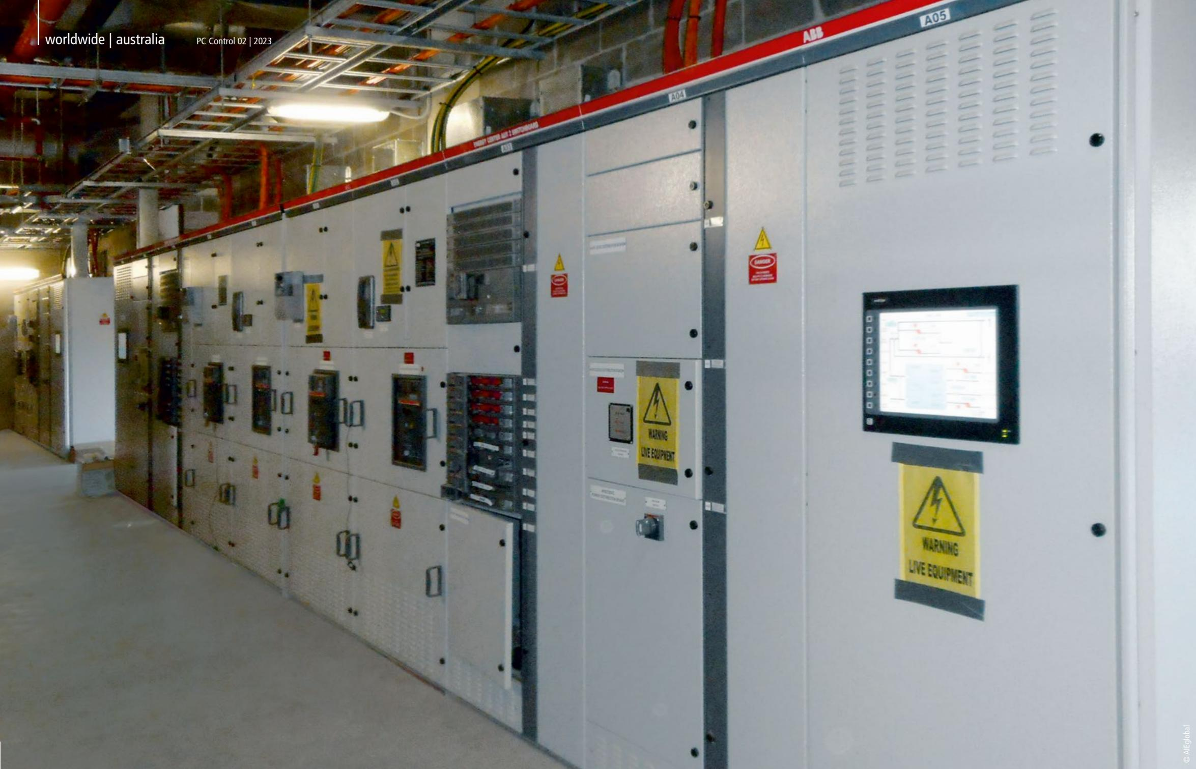
Durch die EtherCAT-Kommunikation konnte der Umfang der Anlagenverkabelung verringert und die Größe der zentralen Steuerungsanlage auf eine Schaltschrankschrankreihe reduziert werden.
