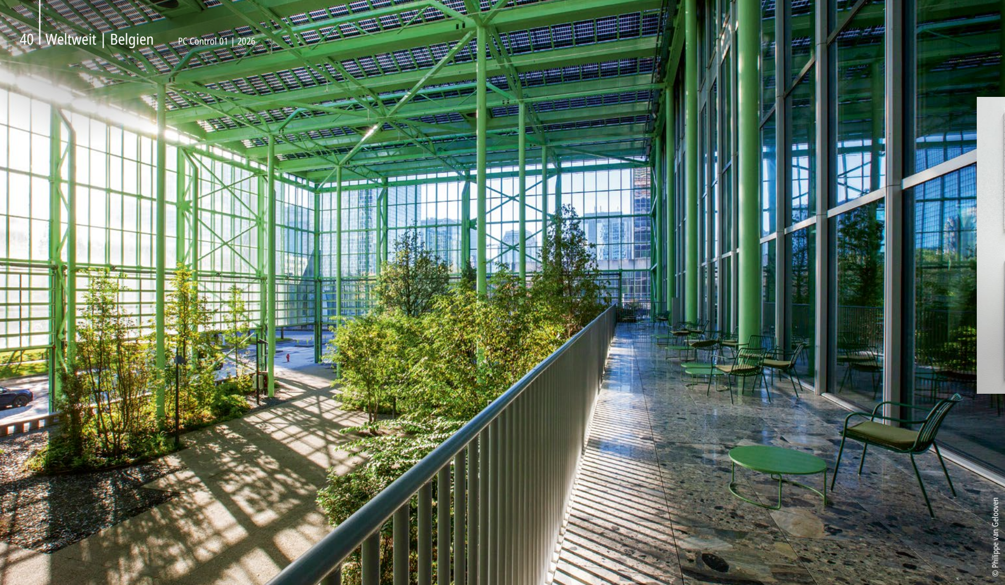
Den jährlich sinkenden Energieverbrauch, den die flämische Regierung als Eigentümer vorgibt, unterstützen Maßnahmen wie die automatische Steuerung und Beschattung der Fenster.
