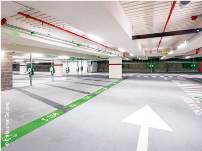
Die intelligente Lichtsteuerung spart rund 66 % Energie ein.
