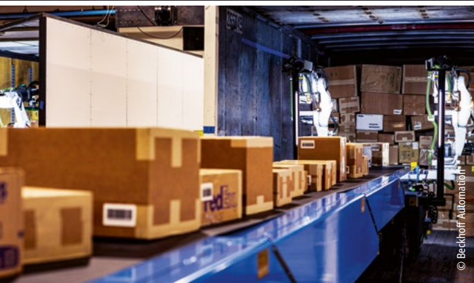
Oben: Dexterity nutzt die leiterplattenmontierten EtherCAT-Steckmodule der Serie EJ von Beckhoff anstelle herkömmlich verdrahteter I/O-Klemmen, um den Verkabelungsaufwand zu minimieren und die Effizienz der Serienproduktion zu maximieren.
