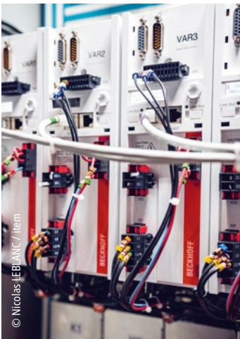
Im Sinne offener und flexibler Lösungen werden die unabhängigen Kontrollpartien des Bühnenbilds über fünf Servoverstärker AX5103 gesteuert.
