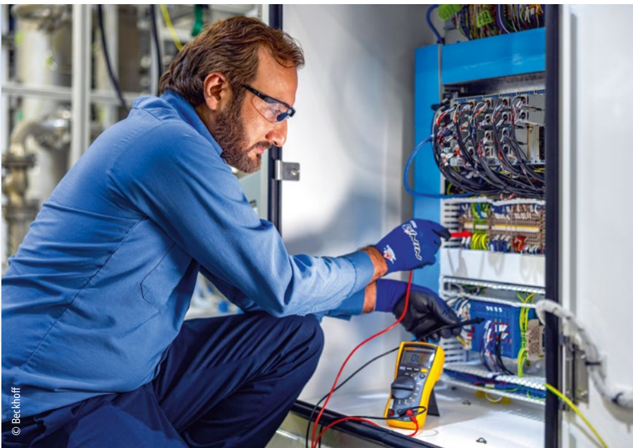
Greenlight nutzt neben den Standard-EtherCAT-Klemmen von Beckhoff auch TwinSAFE-Klemmen für integrierte funktionale Sicherheit und ELX-Klemmen für den Anschluss von Feldgeräten in explosionsgefährdeten Zonen.
